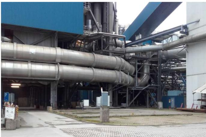
Bild 2: Rauchgaskanäle einer Müllverbrennungsanlage
