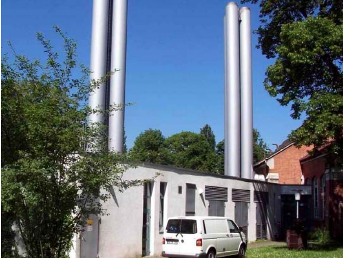
v.l.n.r. BHKW-Gebäude mit Kaminanlage, Kesselhaus mit Kaminanlage
