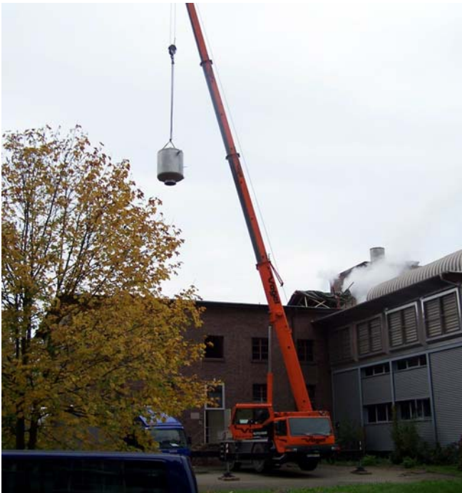
Einbringung des Edelstahl-Rieselentgasers 40m 3 /h über das Dach
