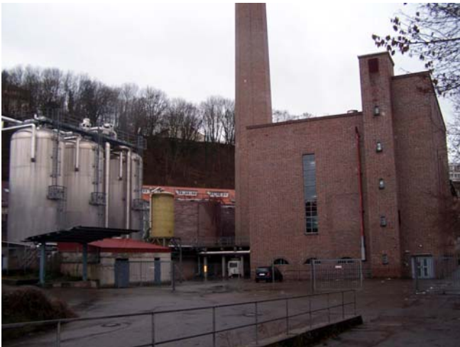
v.l.n.r. Dampfspeicher, Öltankanlage, Kaminanlage, Heizwerk
